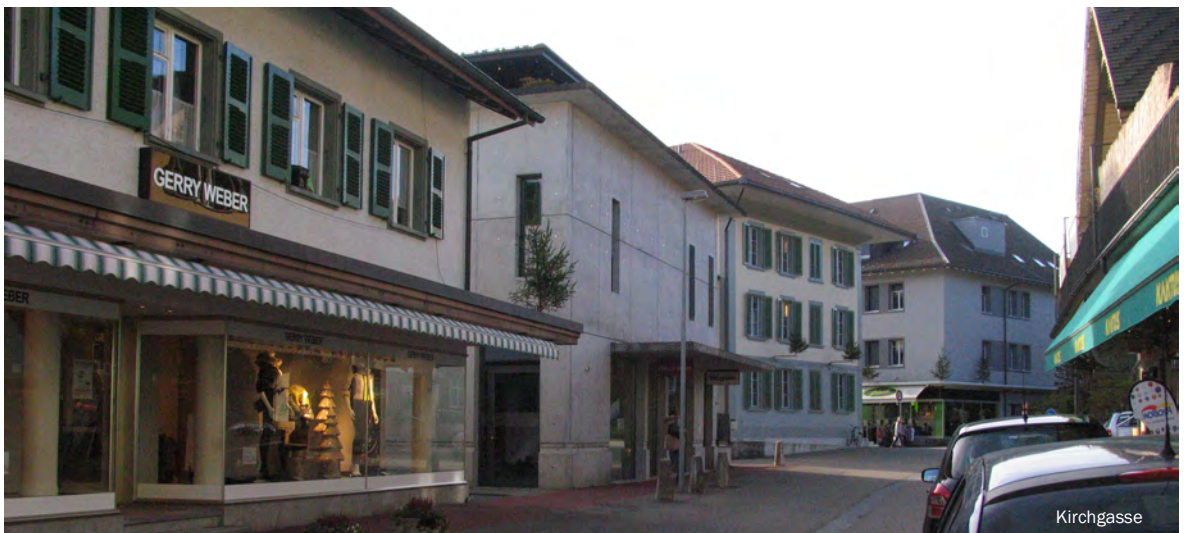
Abbildung 16: Illustration der Stellung der Bauten gegenüber dem Strassenraum und dem öffentlichen Raum
