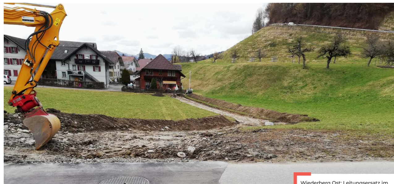
Wiederberg Ost: Leitungsersatz im Bereich der alten Käserei
