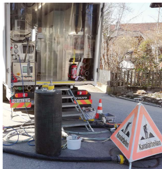
Installationen für grabenlose Leitungsinnsanierung (Inlinerverfahren)
