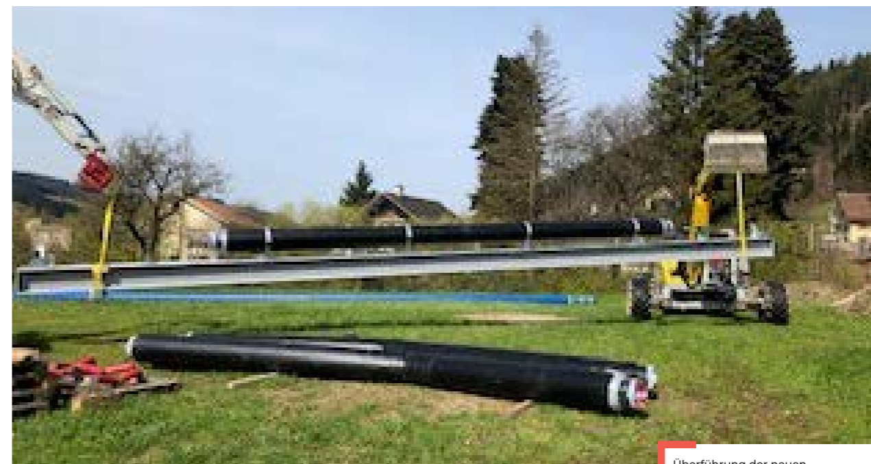
Überführung der neuen Wasserleitung über die Trub
