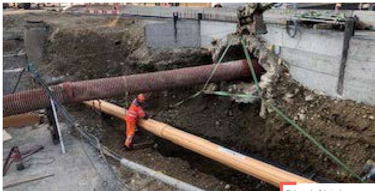
Einlegen des Schutzrohrs mit der neuen Wasserleitung
