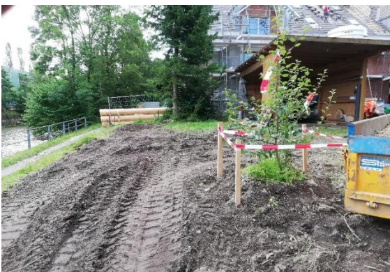
Bau Abwasserleitung Ilfis
