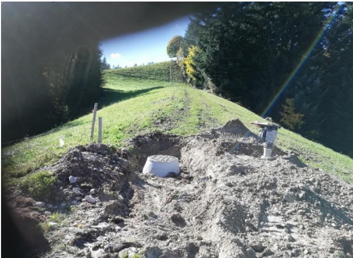
Erschliessung Abwasserleitung Hochwacht
