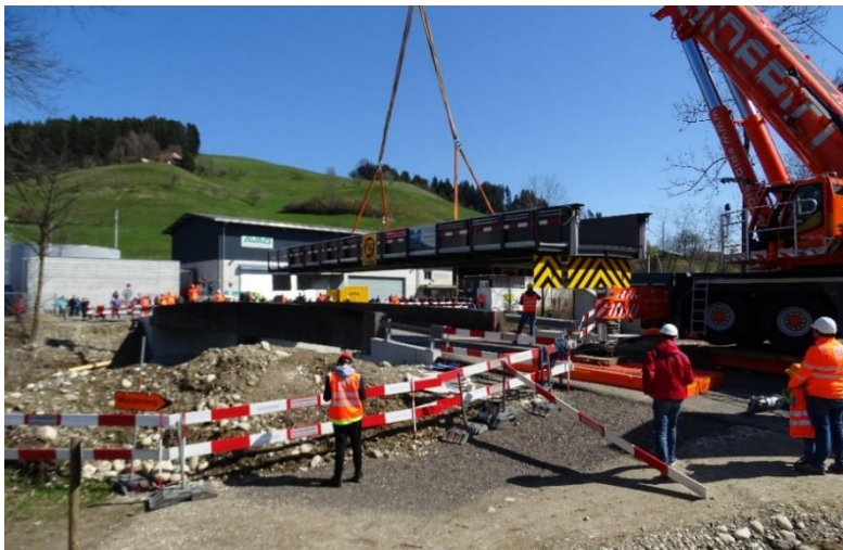
Versetzung neue ARA-Brücke
