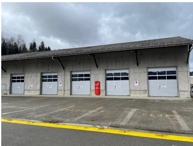
Provisorium Feuerwehrmagazin bei der Zeughausmatte
