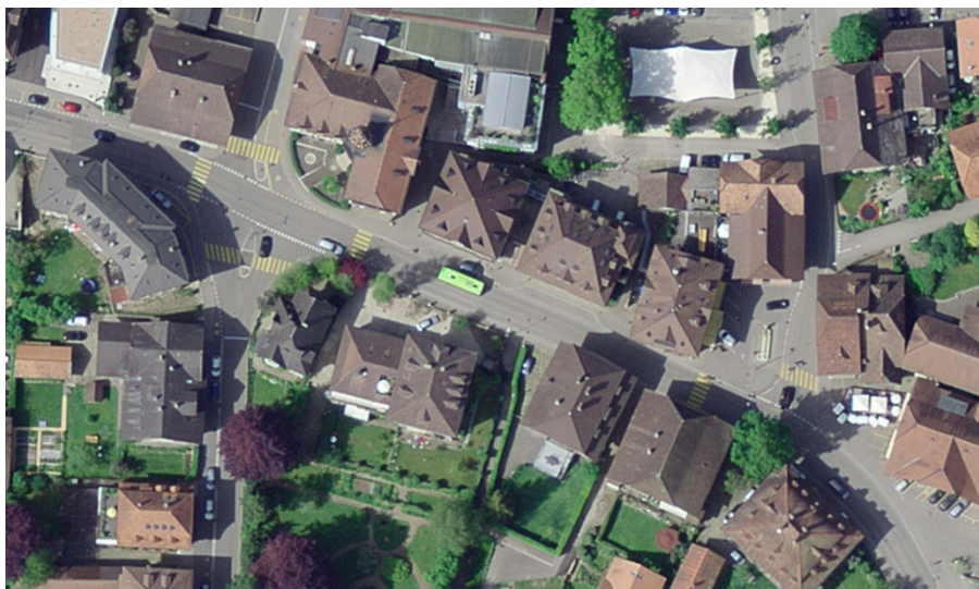
Abb. 2 Ortstypische Dachformen entlang der Dorfstrasse 4–16 (Quelle: SwissImage, Powered by OSTAG)
