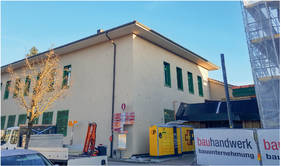
Schlechter Empfang im Dorfzentrum seit Antennen-Abrüstung. | Bild: S. Lauener
