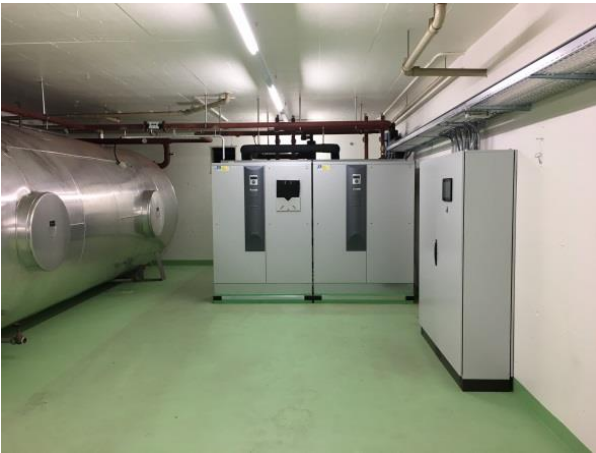
Grundwasser-Wärmepumpe
