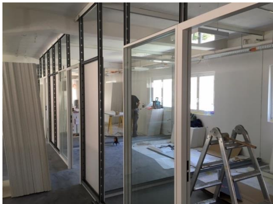
Einbau von Büros im Erdgeschoss
