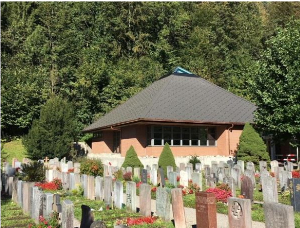
Sanierung Dach und Einbau Glasfirst
