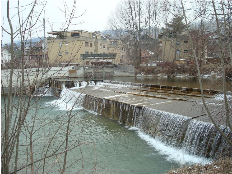
Abbildung 2 Ansicht Wehranlage (oberste der drei Schwellen)
