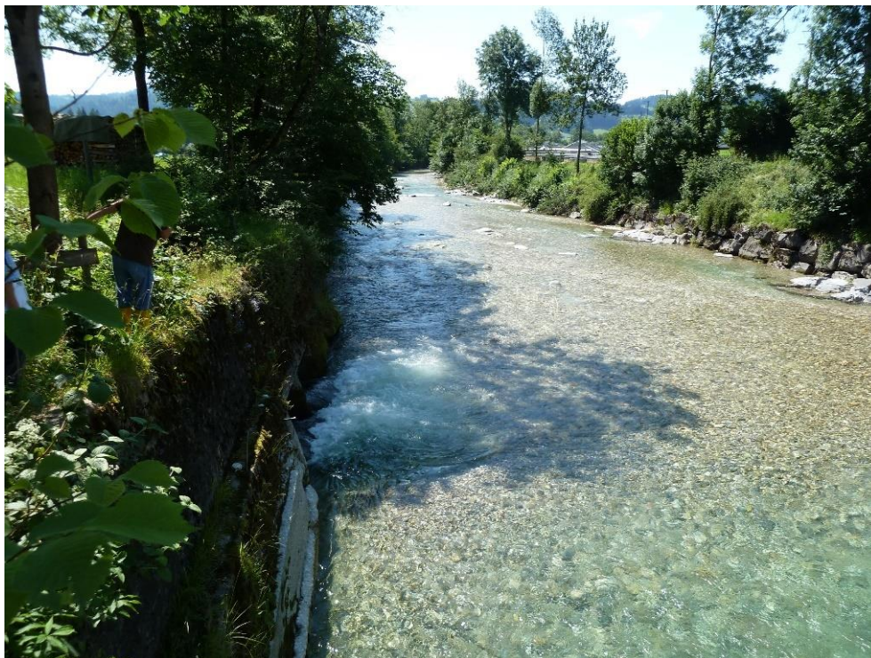
Abbildung 7: Wasserrückgabe in die Iffis
