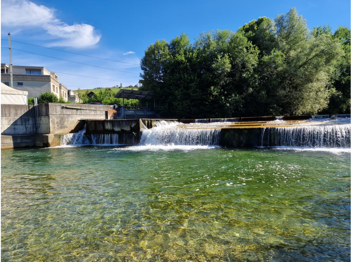
Tromschwelle an der Ilfis bei Langnau i.E., 05.07.2024
