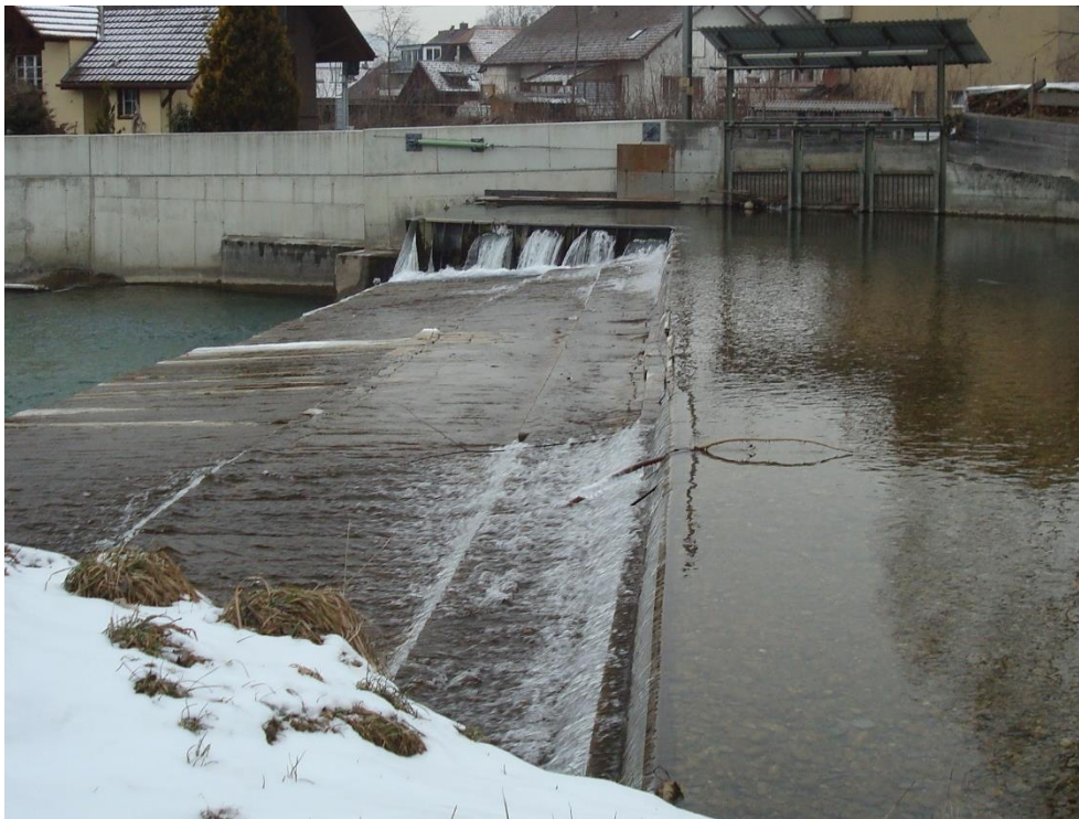
Abbildung 8: Wehrrücken mit Dotieröffnungen
