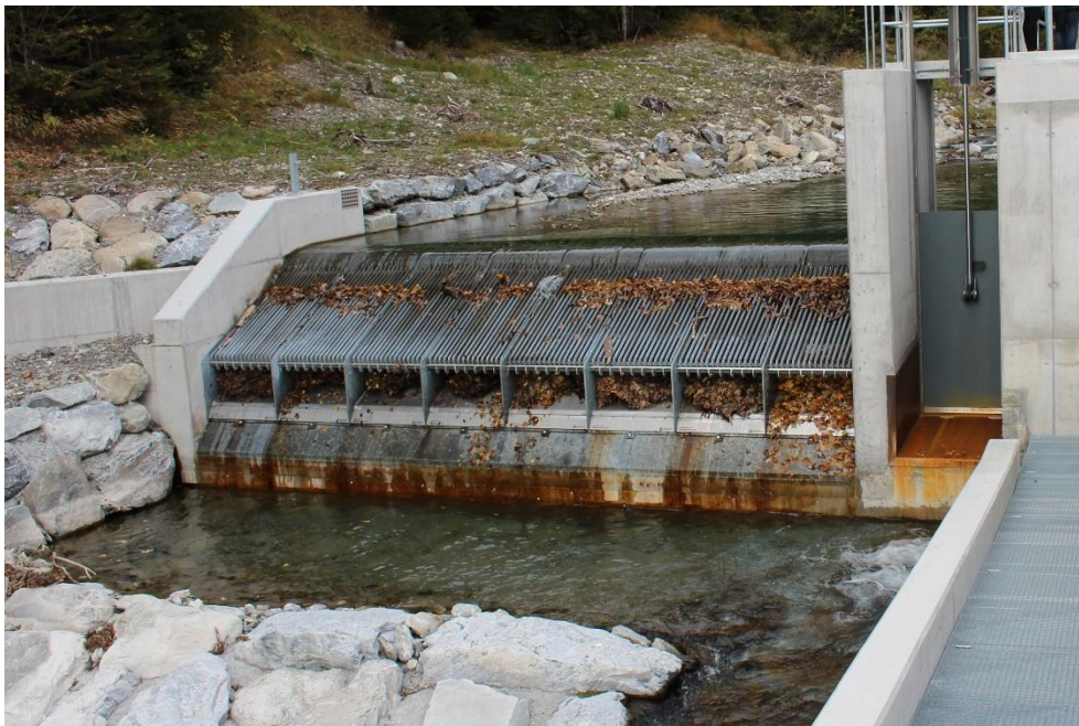
Abbildung 11: Beispiel einer Wasserfassung mit Coandafeinrechen: KW Schanielabach, St. Antönien (hydraulischer Höhenverlust = 1.95 m bei 2.0 m 3 /s Entnahme)
