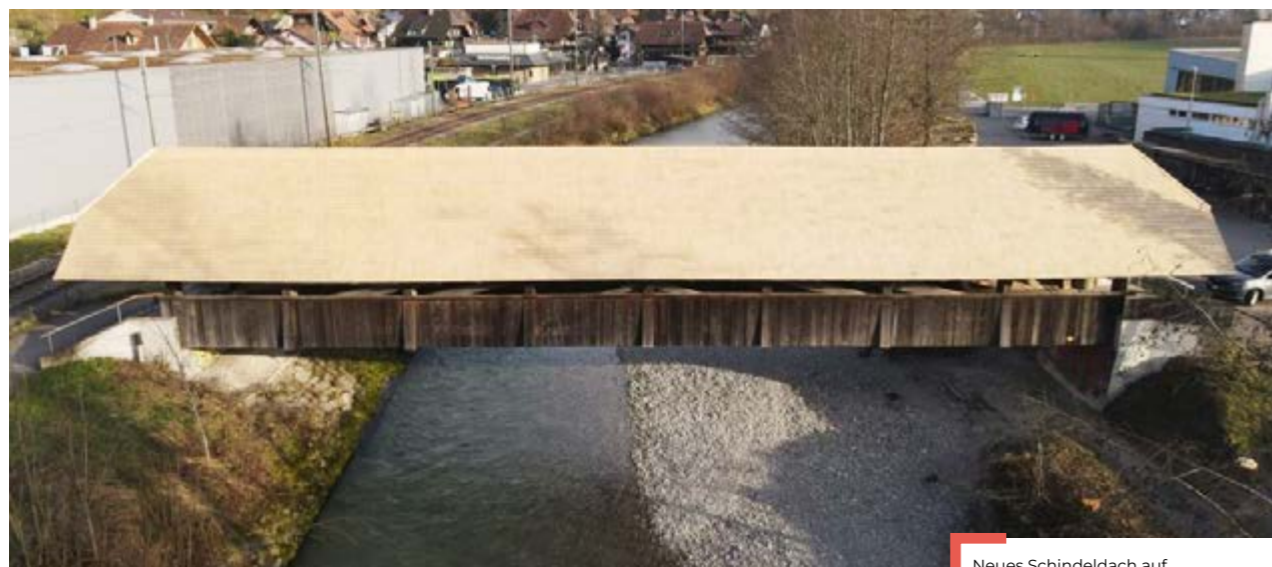
Neues Schindeldach auf der Moosbrücke
