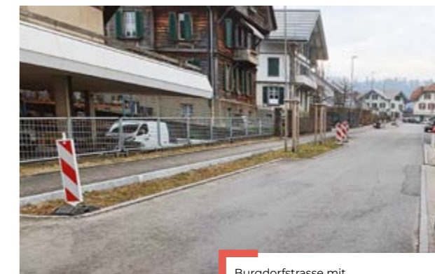
Burgdorfstrasse mit Schwammstadtelementen
