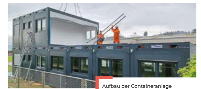
Aufbau der Containeranlage
