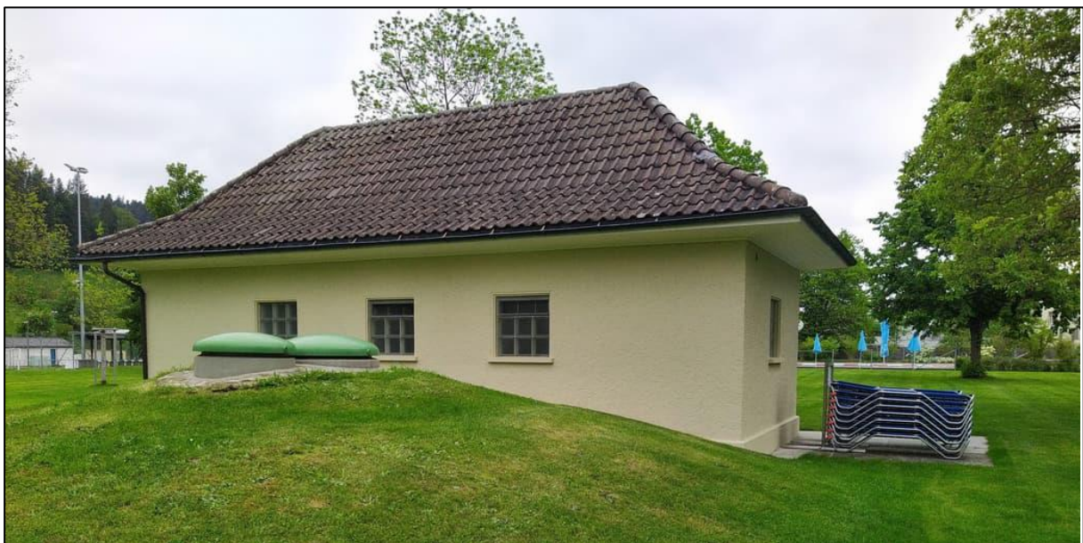
Abbildung: Heutiges Pumpwerk auf dem Areal des Hallen- und Freibads
