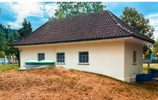
Sie muss verlegt werden: die Grundwasserfassung Moos auf dem Areal der Badi Langnau.
